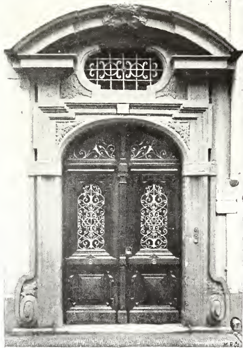
Portal Herrenstrasse No. 45.
